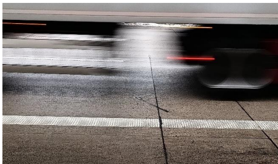
Abbildung 5 Fahrbahnsensoren zur Messung des Salzgehaltes des Flüssigkeitsfilms
