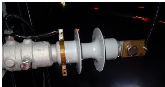
Abbildung 3 Anschluss der Referenzisolatoren an die Fahrleitungsspannung und Schelle zum Abgriff des Ableitstromes
