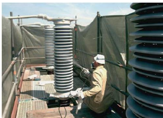
Abbildung 8: Beschichtung von Porzellandurchführungen eines Transformators mit Siliconcoating
